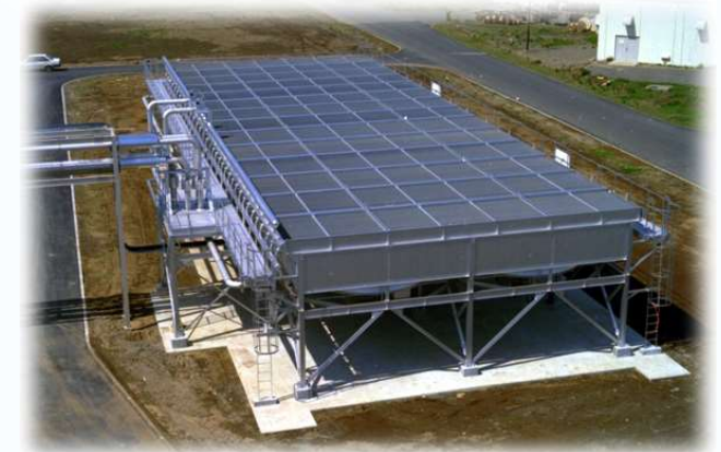
非常用空冷式熱交換器(AFC)
